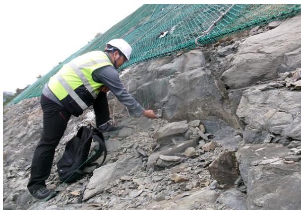
절리면 경사/경사방향 측정
